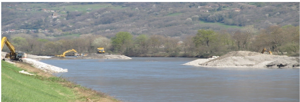
Extraction de graves dans le lit de l'Isère .Ces graviers seront utilisés pour le projet
