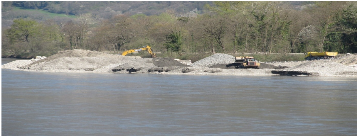
Extraction de graves dans le lit de l'Isère .Ces graviers seront utilisés pour le projet
